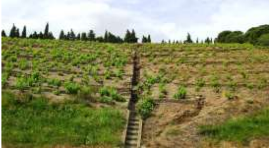
Figure 8. Systèmes de collecte des pluies intenses en « patte d'oie » à Banyuls. Ce vignoble est implanté sur de très fortes pentes. Les vignes y sont aménagées en terrasses et entrecoupées d'un réseau de canaux destinés à évacuer efficacement l'eau lors des fortes pluies. (Pitte J. R. 2002)
