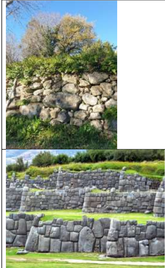
Figure 2. Terrasses constituées d'assemblage de blocs de pierre le plus souvent récupéré localement (en haut Laroque des Albères dans le Roussillon, Photo J. Rochard) et éventuellement taillées (en bas site archéologique de Sacsayhuaman à Cusco au Pérou. Photo Thomas Gleyze)
