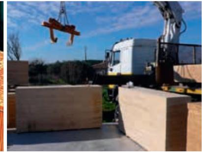
Une bonne inertie thermique d'un bâtiment peut être obtenue tenue avec une pierre massive. Exemple de la pierre du Gard, (photoparchitecture-en-pierre.blogspot.com) et des briques alvéolaires « monomur » de grande largeur, Photo www.travaux.com
